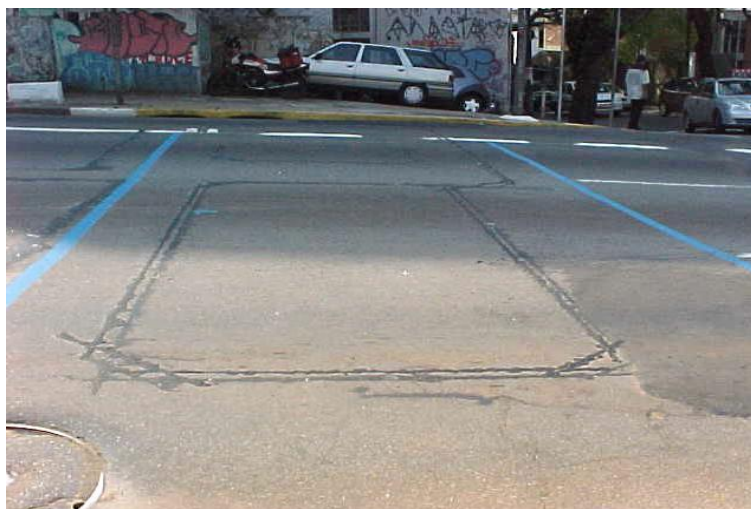
Figura 19: Laço detector implantado em via.
