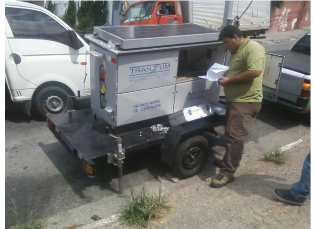
Figura 35: Nota-se compartimento com local adequado para abrigar o computador, e acima da unidade, uma placa responsável por captar energia solar.
