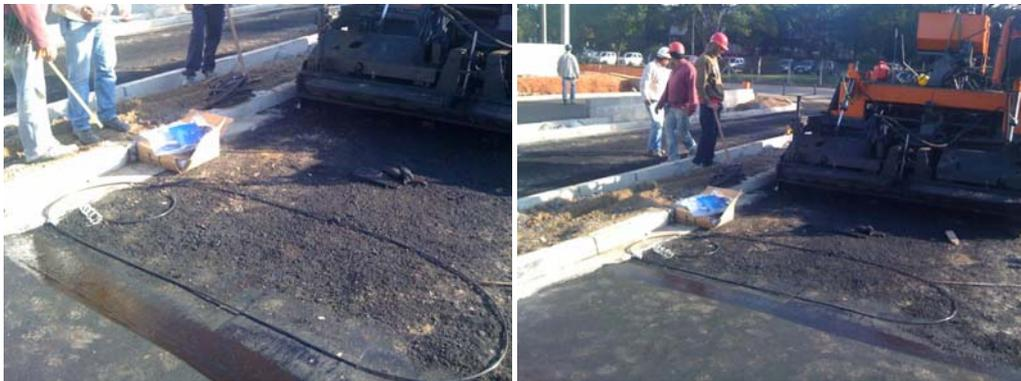
Figura 13 - Laço Indutivo sendo instalado no pavimento – Fonte: NISHIMOTO, 2006.
