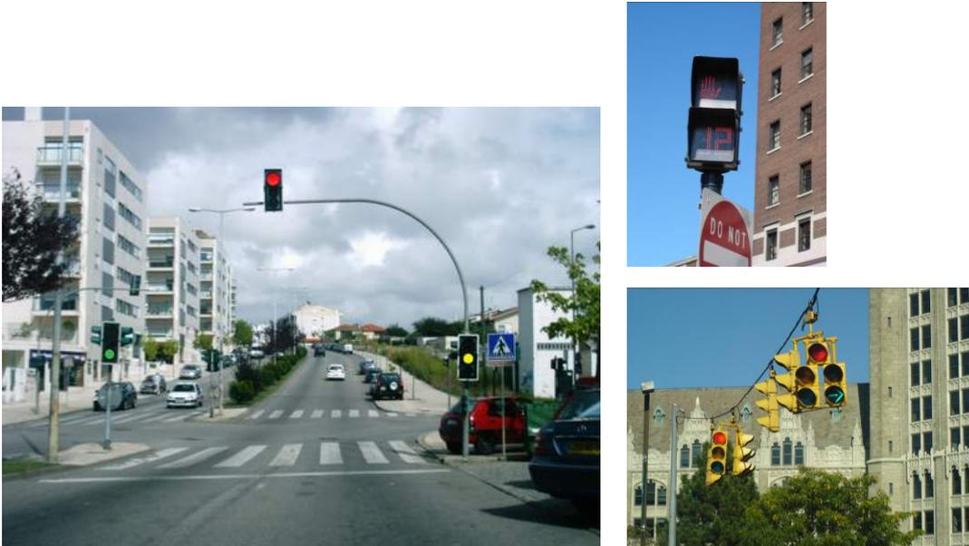
**Figura 3 – Fotografias de colunas, báculo e suspensão por cabos**
