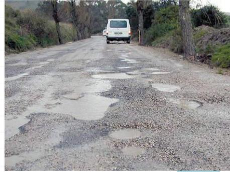
Pavimentos degradados obrigam os condutores a concentrarem-se conscientemente na tarefa de controlo, distraíndo-os da tarefa de guiamento (em especial quanto à interacção com o restante tráfego).
