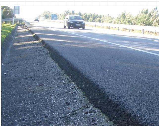
Transições entre zona pavimentada e bermas ou taludes não devem ter ressaltos que instabilizem o controlo das viaturas.
