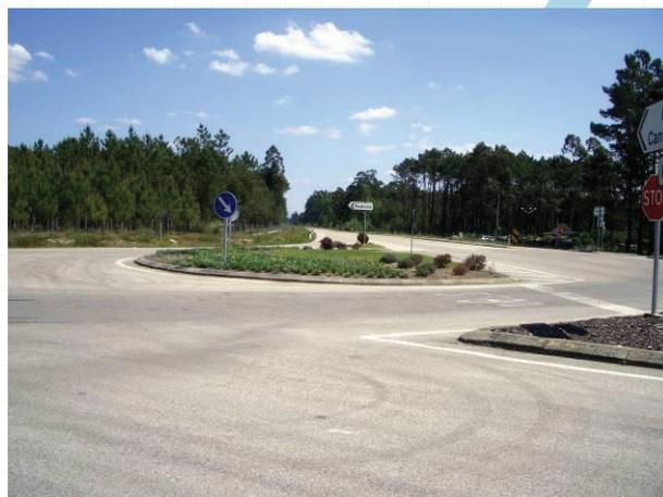
Numa intersecção, a disposição geral e a localização dos ilhéus direccionais deveriam auxiliar a tarefa de condução, o que requer a conformidade com esquemas gerais de desenho facilmente reconhecíveis e a imposição de efectivas restrições à liberdade de escolha de trajectórias.
