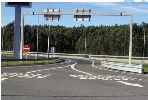
Os sinais verticais devem ser colocados do lado direito, sendo duplicados do lado esquerdo em faixas de rodagem unidireccionais.
