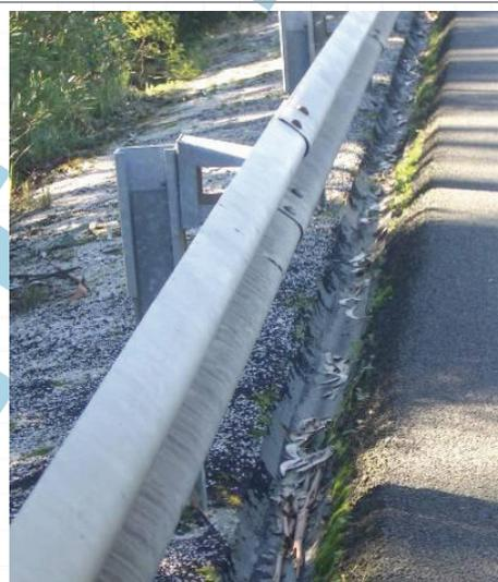
Uma outra maneira de resolver o problema dos terminais consiste em ligar a barreira que se pretende interromper a uma de outro tipo (o que, por sua vez, obriga à adoção de medidas que solucionem os problemas específicos relacionados com a transição entre as duas barreiras). Por exemplo, frequentemente as barreiras de betão de cimento terminam por transição para barreiras metálicas.
