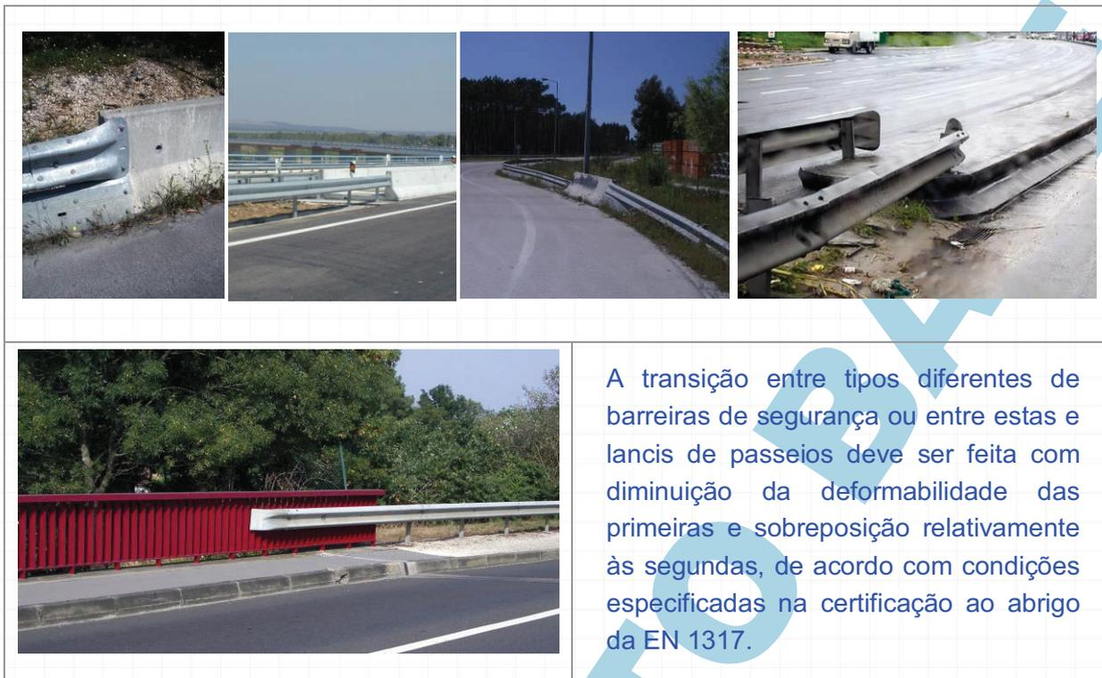
A transição entre tipos diferentes de barreiras de segurança ou entre estas e lancis de passeios deve ser feita com diminuição da deformabilidade das primeiras e sobreposição relativamente às segundas, de acordo com condições especificadas na certificação ao abrigo da EN 1317.
