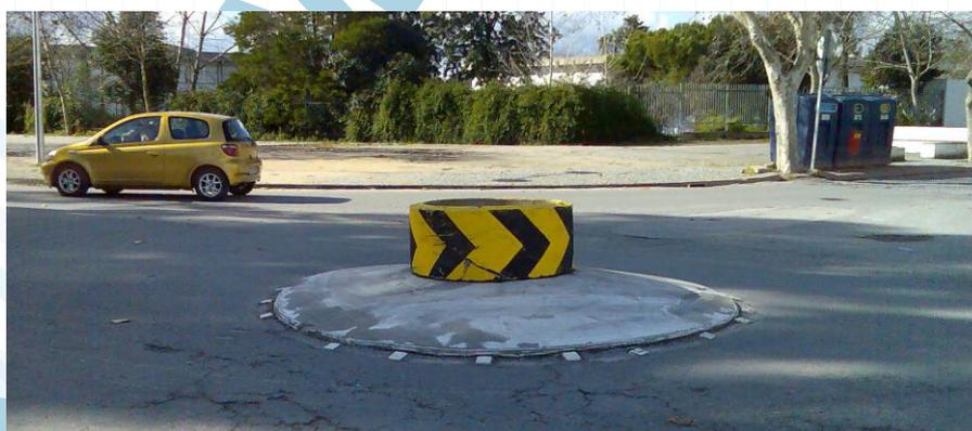
Figura 5. 17 - “Sinalização” de míni rotunda torna a ilha intransponível
