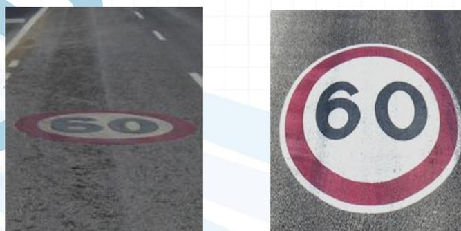
**Figura 6. 20** - Sinais colados no pavimento - circular e alongado
