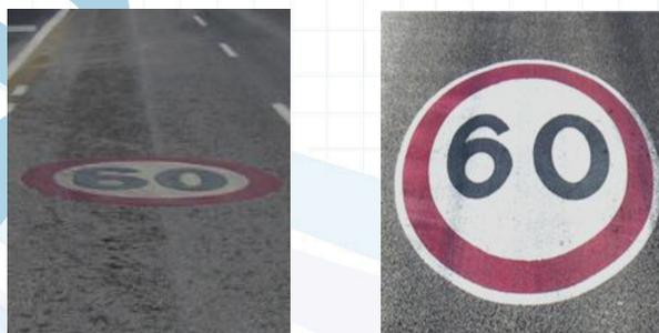
Figura 2. 20 - Sinais colados no pavimento - circular e alongado
