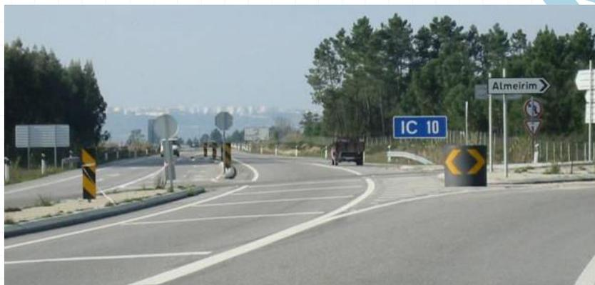
Figura 3. 29 - Utilização incorrecta do sinal O5b num entroncamento
