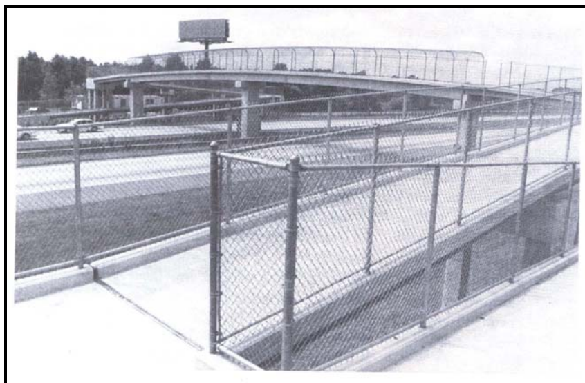
Figura 16 – Passarela sobre Via Arterial Primária
