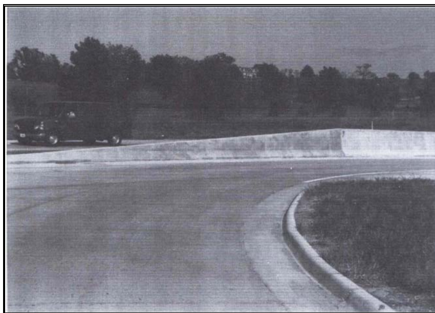
Figura 93 – Elevação Gradual da Crista de uma Barreira de Concreto
